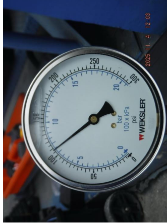
รูปที่ 64 Discharge Pressure ที่อ่านค่าได้เท่ากับ 108 psi.
